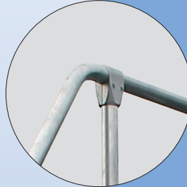
Alakzáró, tömör csatlakozás a kapaszkodó és a dobogókorlát között
